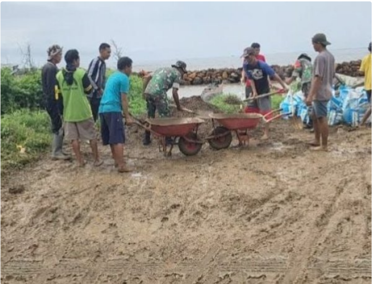
Penataan kampung Pancasila Ungkea
